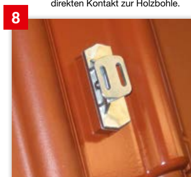
8 Das war's schon! Jetzt ist die Alu-Solar-Trägerpfanne für die unterschiedlichen Energie-Dachsysteme vorbereitet.
