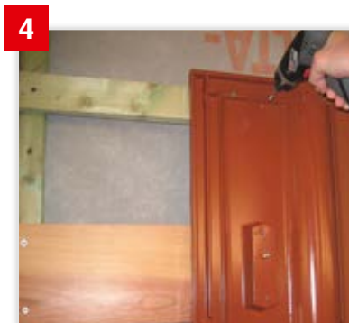
4 Die Alu-Solar-Trägerpfanne mit den beige-fügten Edelstahlschrauben an der Traglatte befestigen.
