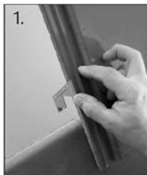
1. Klammer auf Seitenfalz setzen.
