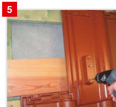
5 Die Alu-Solar-Trägerpfanne mit zwei Edelstahlschrauben in die Holzbohle befestigen. Die Länge der Schrauben ist bauseits zu bestimmen. Die Trägerpfanne hat keinen direkten Kontakt zur Holzbohle.
