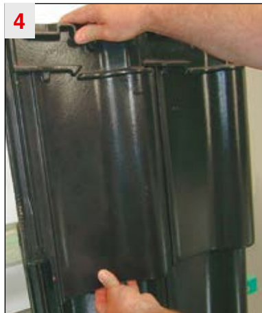
4 Dachziegel eindecken und andrücken. Fertig!
