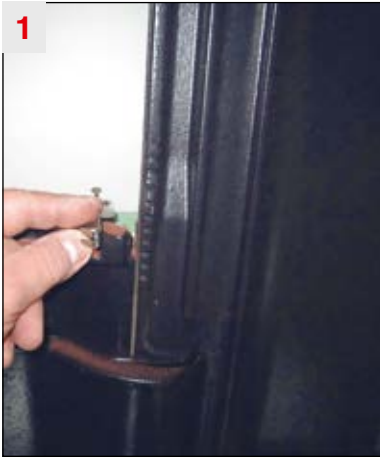
1 Multi-Sturmkralle über den Kopffalz...
