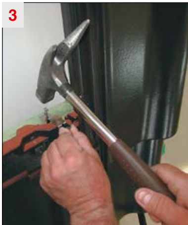
3 ... und von oben in die Traglattung einschlagen.
